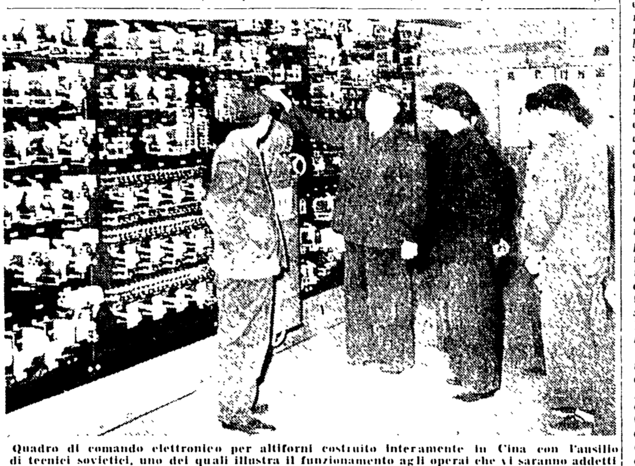
Quadro di comando elettronico per allarmi costruito interamente in Cina con l'aiuto di tecnici sovietici, uno dei quali illustra il funzionamento agli operai che li saranno addetti.
