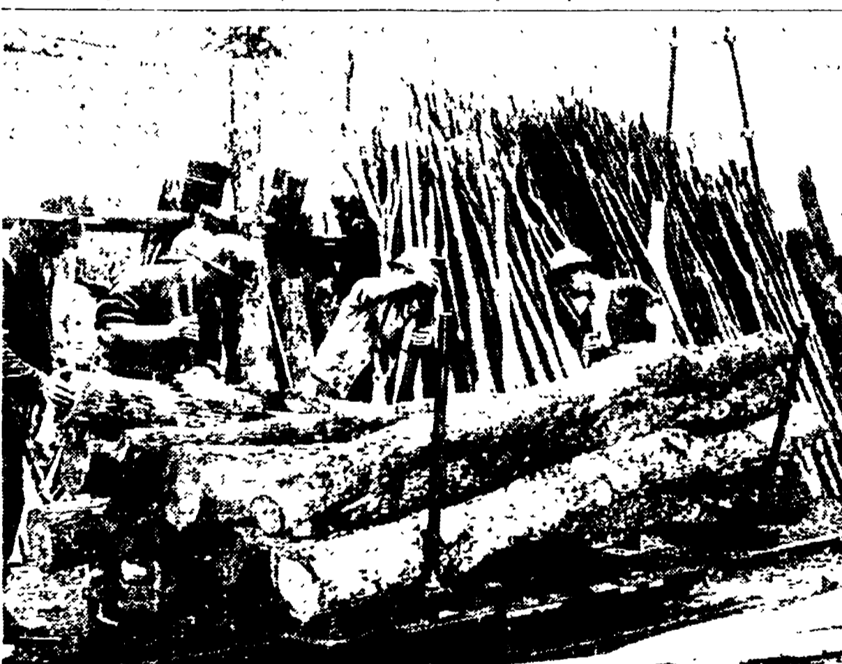
I minatori preparano i tronchi per le armature delle gallerie
