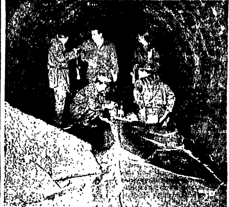
PESCHIERA — Questo è un tratto della galleria nei pressi di Morlupo, dove la platea è risultata dissestata per un tratto di 50 metri. La foto mostra tecnici ed operai nel corso dei sopralluoghi effettuati alla fine della scorsa estate
