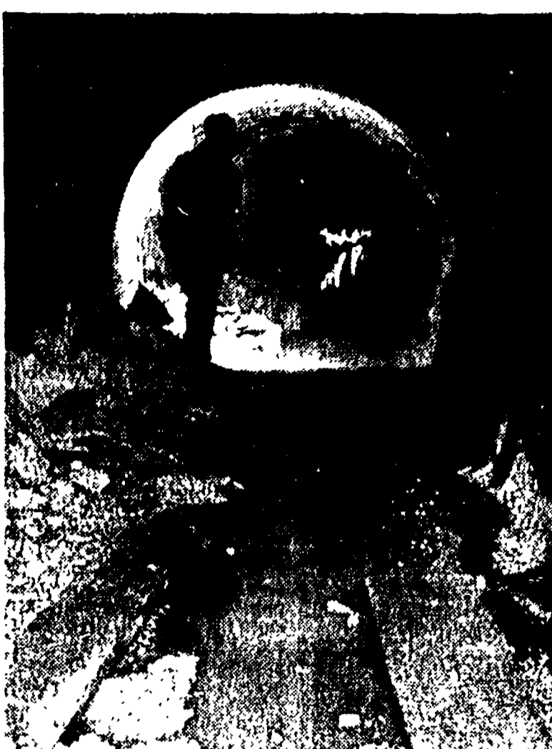
I LAVORI AL PESCHIERA — Proseguono regolarmente i lavori per la riparazione della galleria dell'aquedotto. Secondo le previsioni essi avranno termine fra 20-25 giorni
