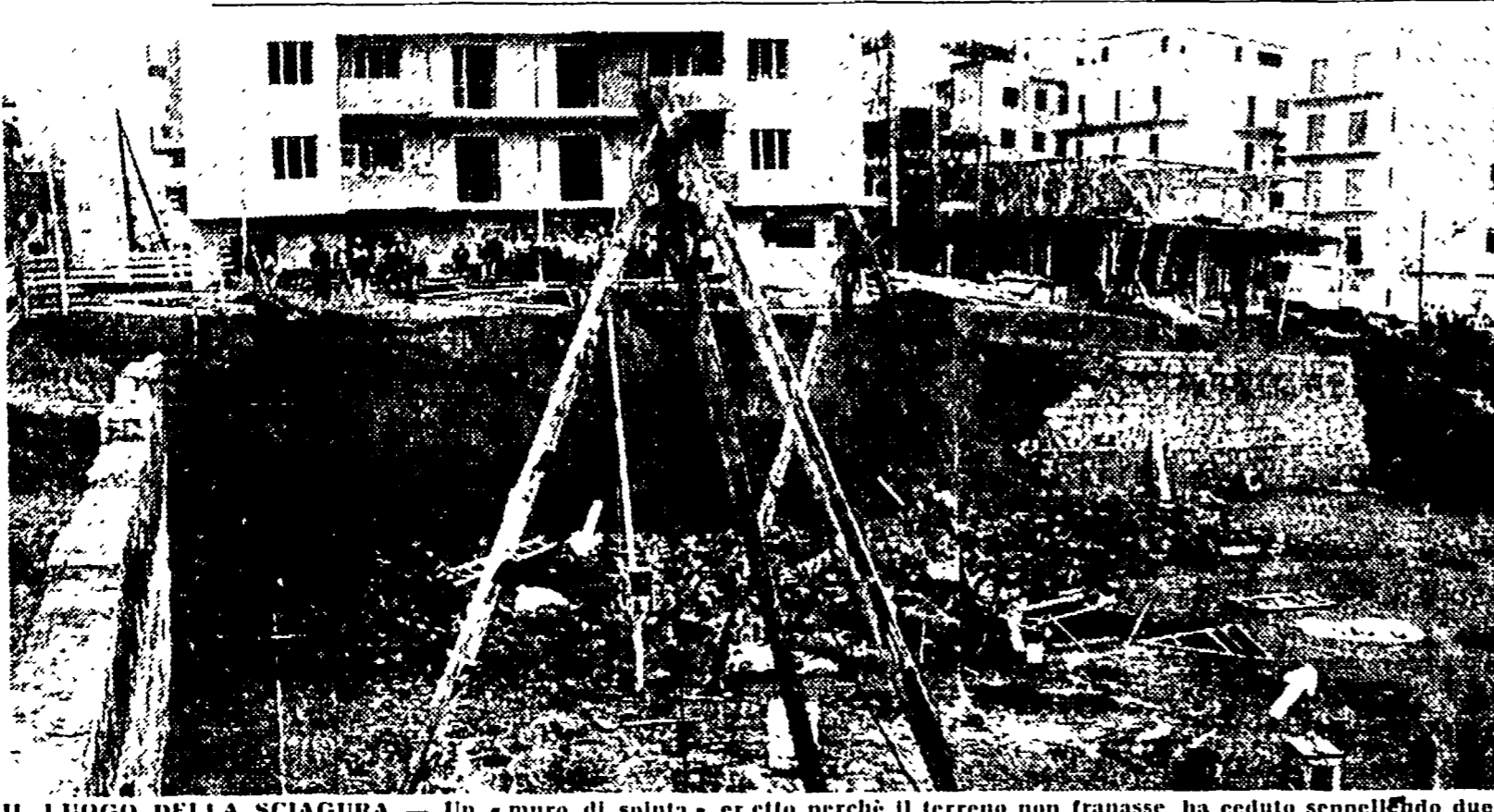
IL LUOGO DELLA SCIAGURA - Un «muro di spinta» eretto perché il terreno non franasse, ha ceduto seppellendo due edili. Nella foto sono visibili le due frecce che indicano le salme dei due operai, ricoperte con due lenzuoli da mani pietose
