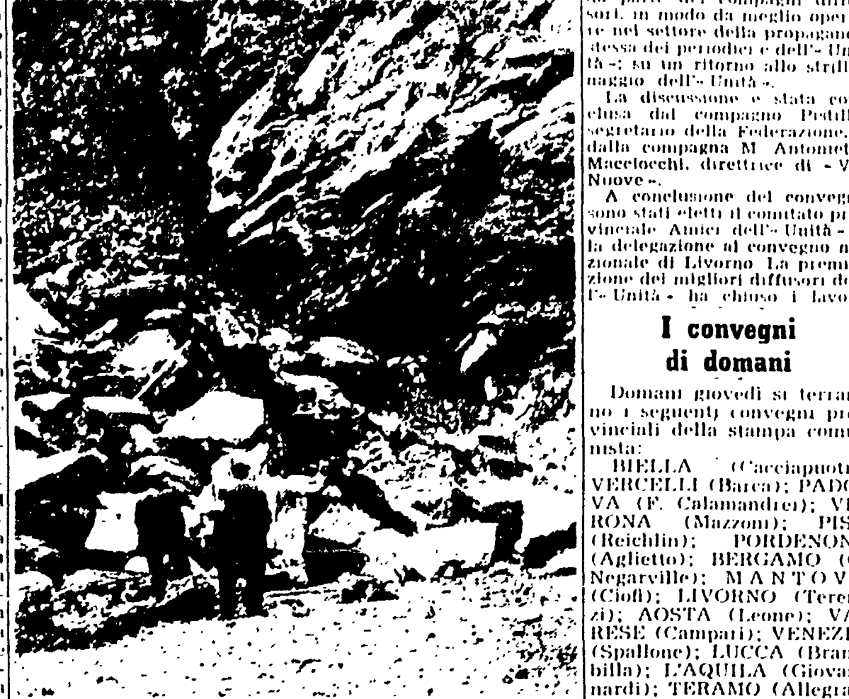
GENOVA — La frana che ha sepolto i tre lavoratori
