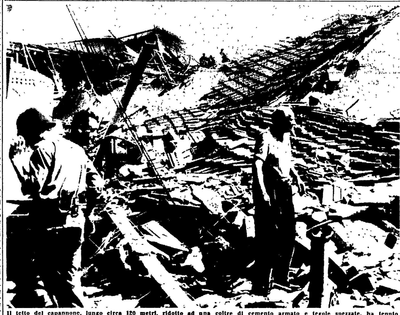
Il tetto del capannone, lungo circa 120 metri, ridotto ad una coltre di cemento armato e tegole spezzate, ha tenuto per alcune ore prigionieri numerosi operai rimasti feriti nel crollo
