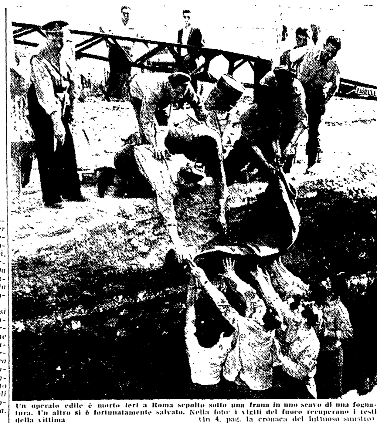
Un operaio edile è morto ieri a Roma sepolto sotto una frana in uno scavo di una fognatura. Un altro si è fortunatamente salvato. Nella foto i vigili del fuoco recuperano i resti della vittima.
