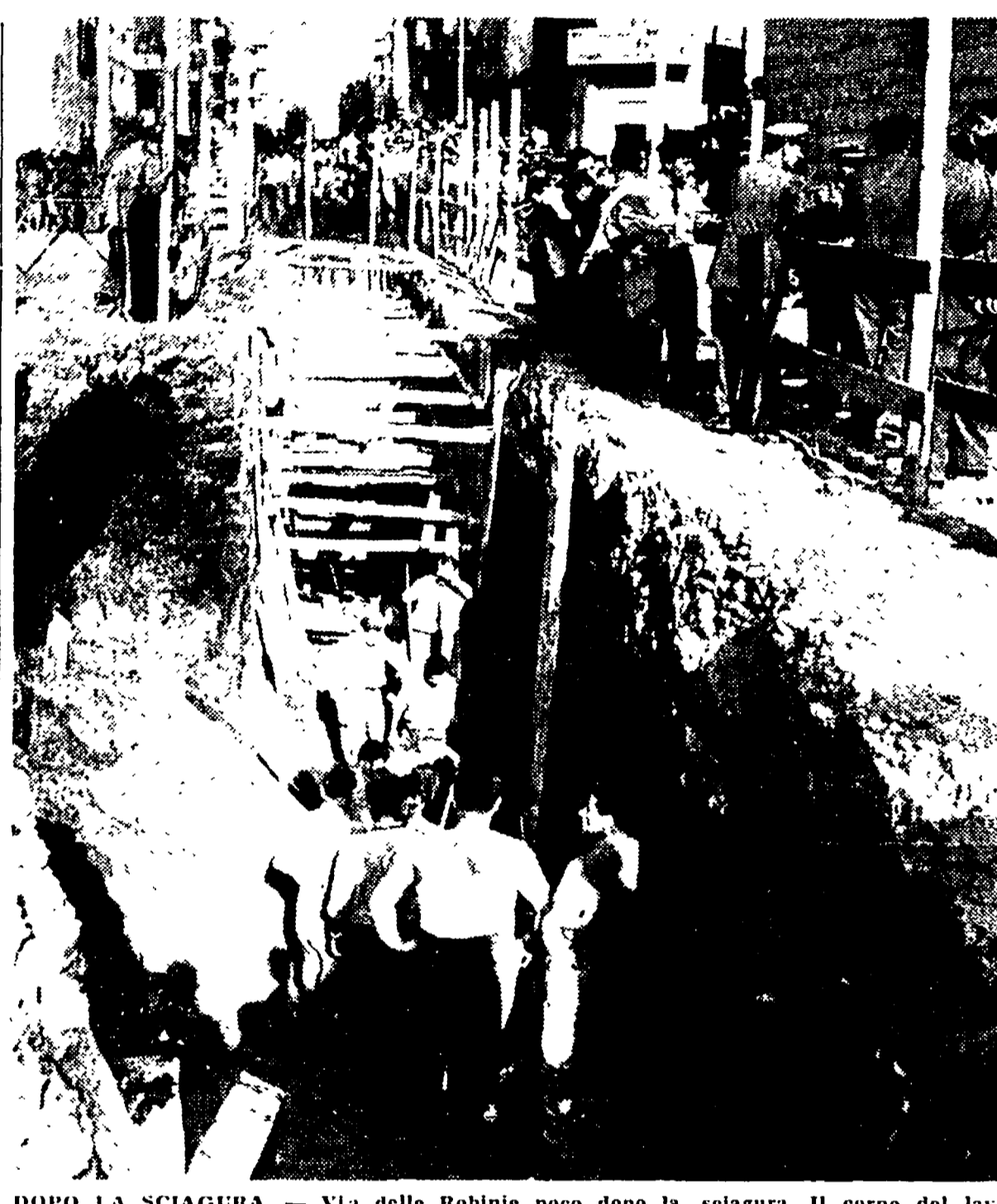
DOPO LA SCIAGURA - Via delle Robinie poco dopo la sciagura. Il corpo del lavoratore morto nella frana è stato da poco estratto dallo scavo
