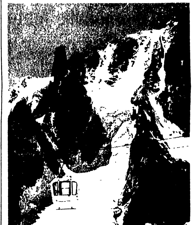
Un altro tratto della traversata. Per superare l'ostacolo fraposto dai tremila metri che separano la stazione della Helbronner dal Gros Rognon si è ricorso ad una variante arditissima del progetto. Tra il Grand e il Petit Flambeau vennero tese sei funi lunghe 311 metri che concorrono a sostenere il cavo portante della funivia e a impedire che affondi nella neve.
