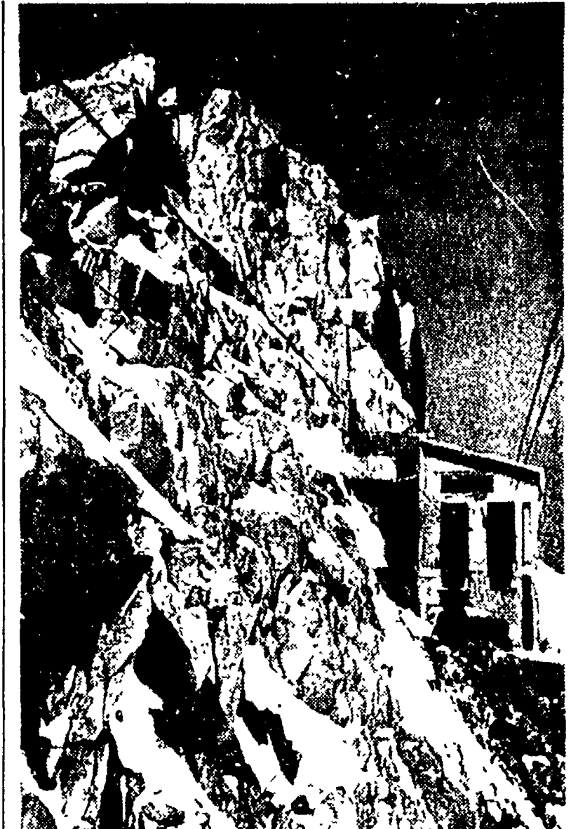
Una stazione della funivia sulle roccie dell'Aiguille du Midi. Fra la punta Helbronner e l'Aiguille du Midi per 5093 metri è stato tesato un cavo di acciaio (14 millimetri di diametro) azionato da un motore autonomo che permette il recupero alla base di partenza di tutte le cabine in qualsiasi momento e in qualunque condizione atmosferica.
