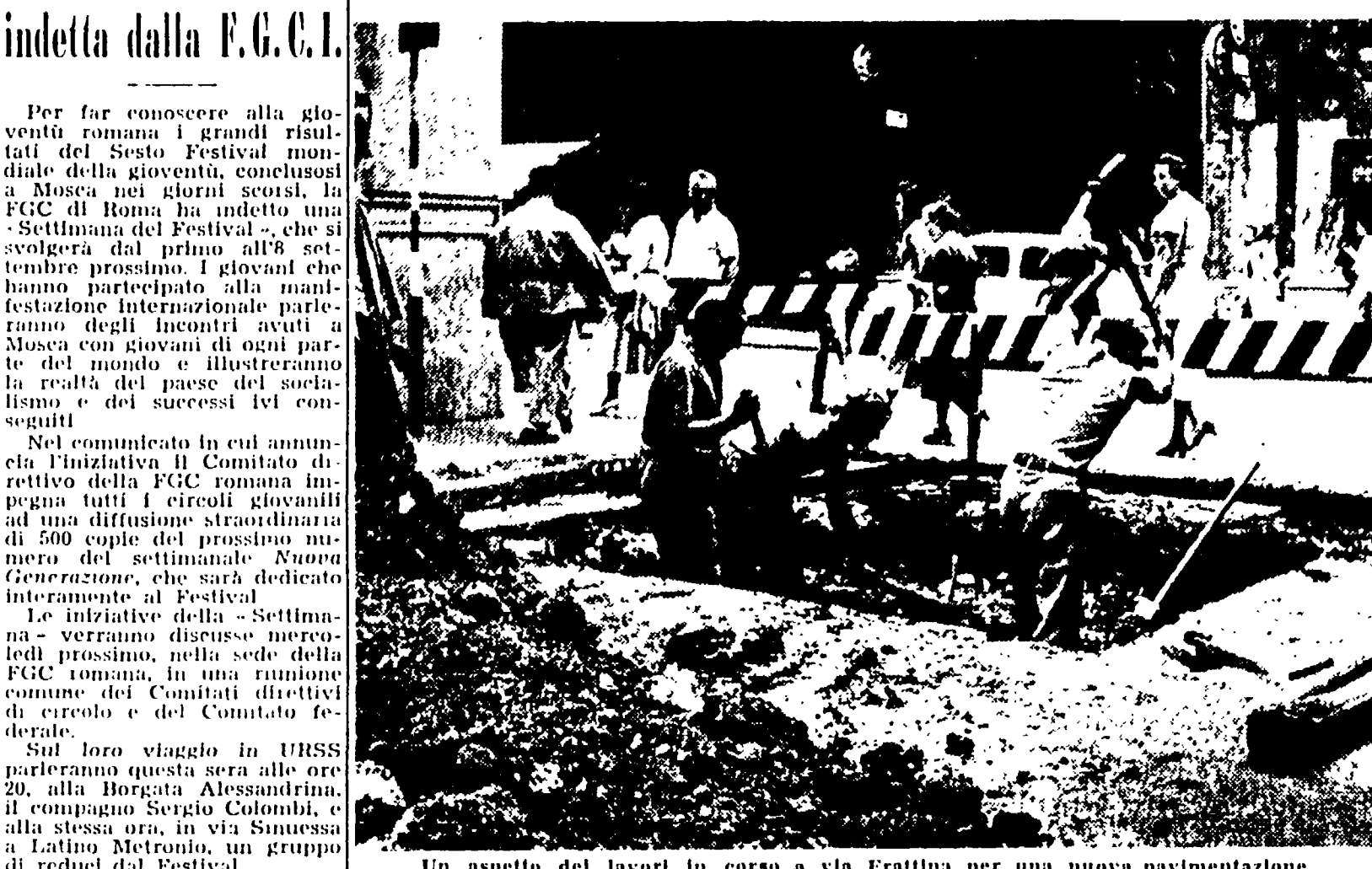
Un aspetto dei lavori in corso a via Frattina per una nuova pavimentazione
