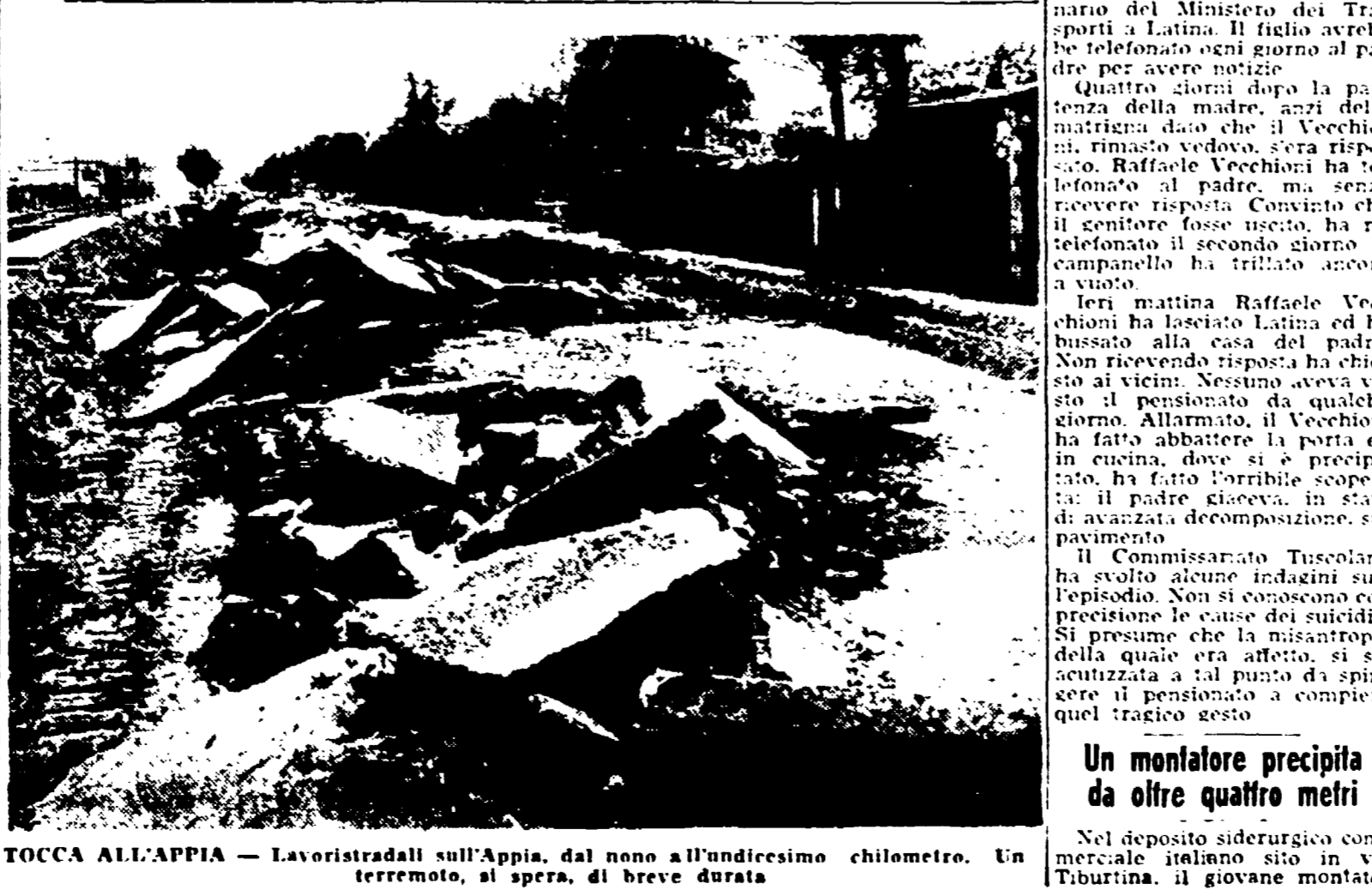
TOCCA ALL'APPIA - Lavori stradali sull'Appia, dal nono all'undicesimo chilometro. Un terremoto, si spera, di breve durata
