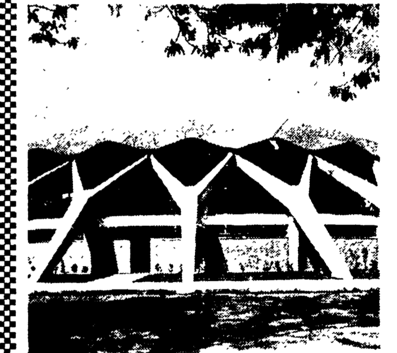
Il Palazzetto dello Sport, costruito dal CONI al viale Tiziano per ospitare una serie di manifestazioni internazionali. La prima delle quali, l'Europea di pallacanestro maschile, avrà luogo domenica prossima, sarà inaugurata oggi pomeriggio alle ore 16. Il pubblico potrà vederlo dalle 18 alle 22. La costruzione è stata completata l'11 settembre di quest'anno e costata 265 milioni ed è comprensiva anche di tutti gli impianti annessi.
