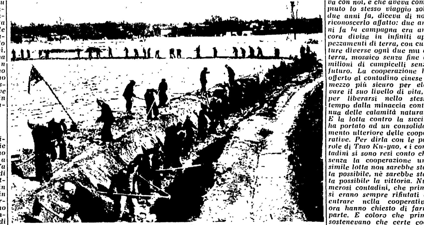
CINA POPOLARE — Contadini di una cooperativa scavano un canale d'irrigazione
