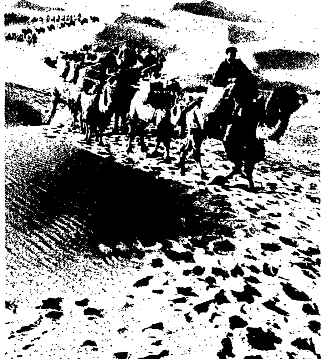
Così si costruiscono le ferrovie nel deserto di Gobi. Lungo le stesse piste che per millenni sono servite ai mercanti di seta e di spezie per i loro traffici con l'Europa, continuano a passare le carovane. Ma è cambiata la mercanzia: oggi i cammelli attraversano i deserti dell'Asia centrale per portare pietre; poi le pietre direzionano, sulla stessa sabbia, la massiccia su cui il treno renderà i rapporti commerciali moderni e rapidi
