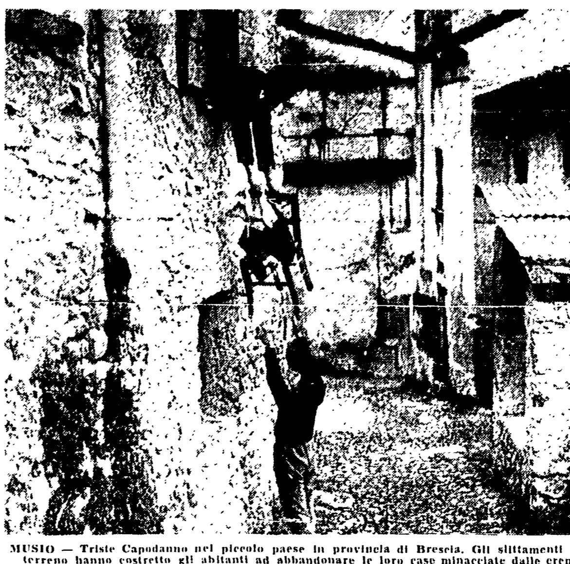
MUSIO - Triste Capodanno nel piccolo paese in provincia di Brescia. Gli siltamenti del terreno hanno costretto gli abitanti ad abbandonare le loro case minacciate dalle erpe...
