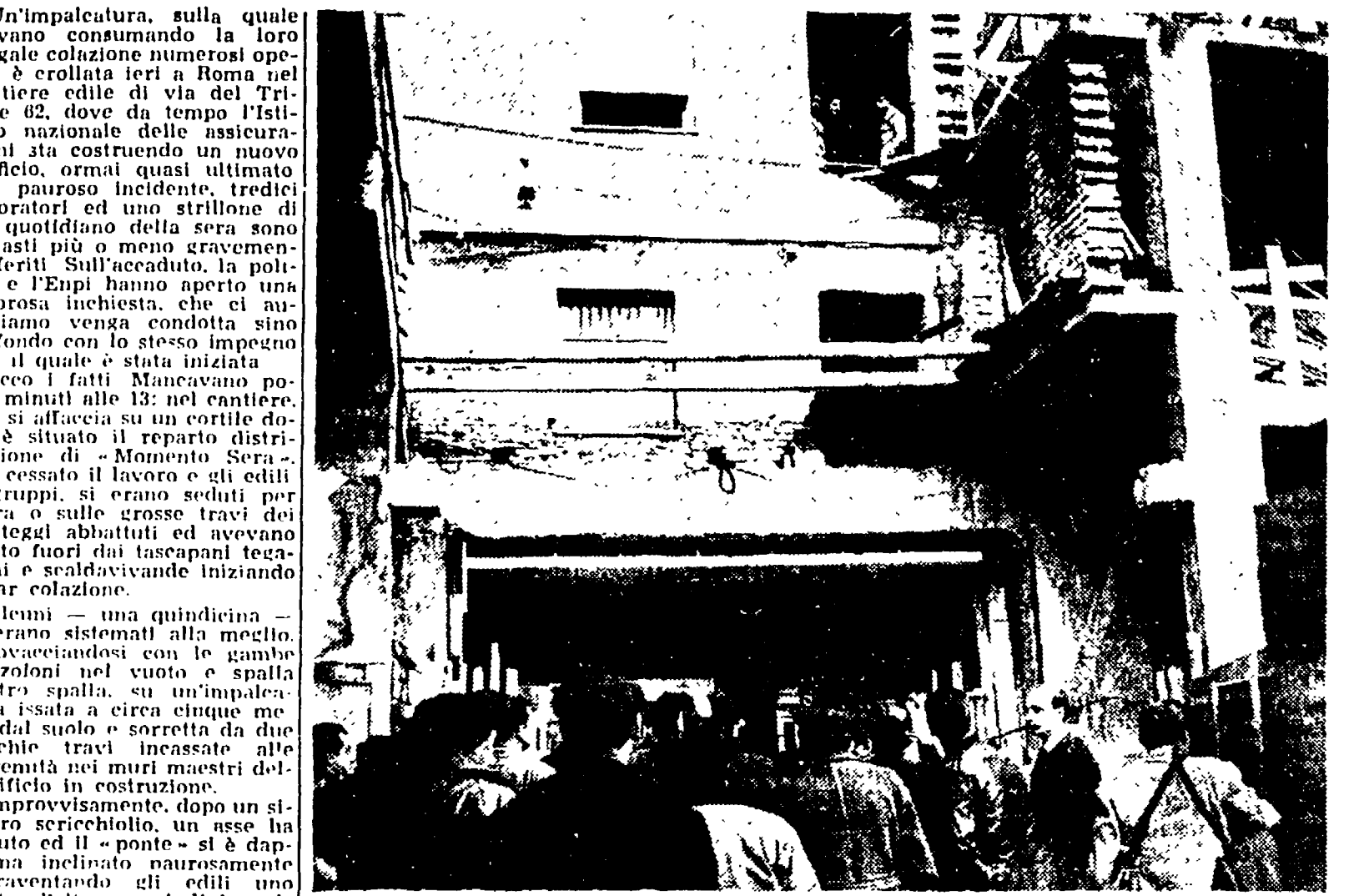
IL LUOGO DELLA SCIAGURA - Il cortile in cui è crollato il ponte
