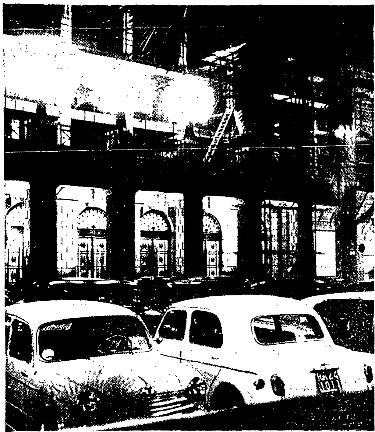
Il piazzale dinanzi all'Opera di Roma, una sera di spettacolo. Lo splendore delle luci non riesce a nascondere i lavori di restauro, conferendo a tutta l'immagine un aspetto di provvisorietà
