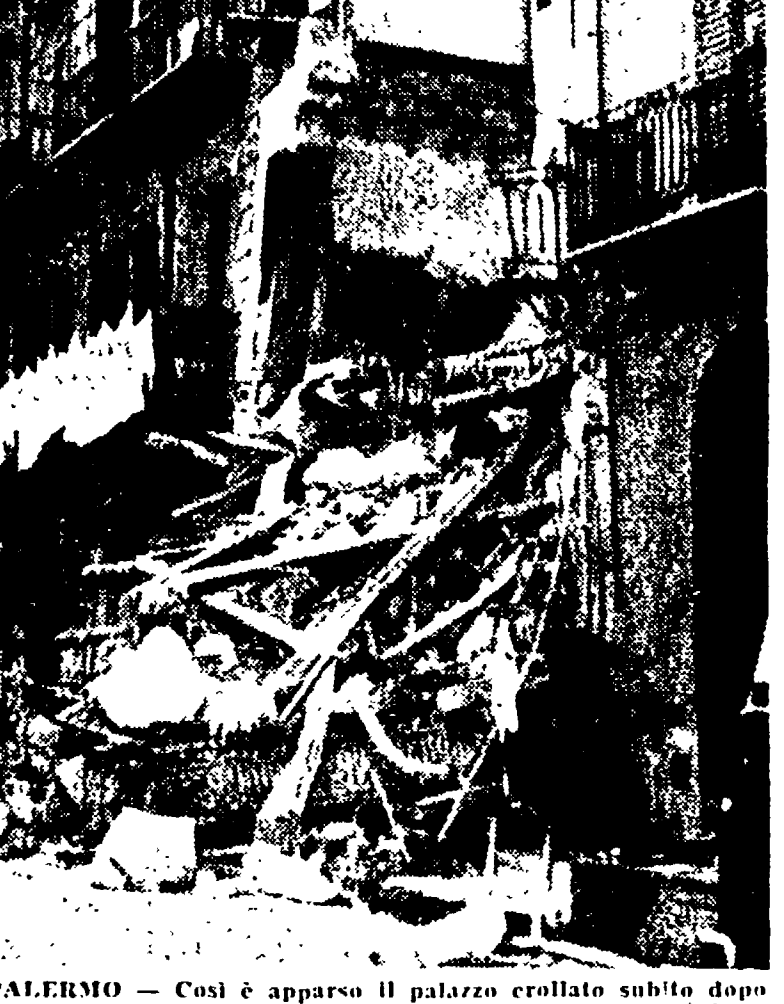
PALERMO — Così è apparso il palazzo crollato subito dopo la catastrofe (Telefoto)
