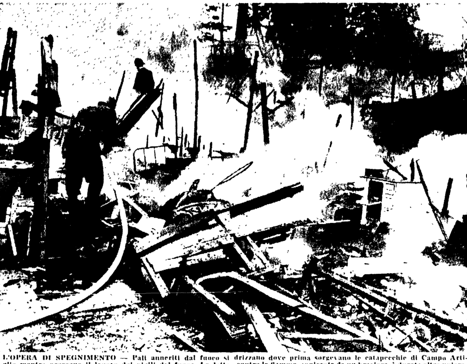
L'OPERA DI SPEGNIMENTO - Palli anneriti dal fuoco si drizzano dove prima sorgevano le catapecchie di Campo Artiglio mentre prosegue il lavoro dei vigili del fuoco. La lotta contro le fiamme, appiegate da un braciere, è durata oltre un'ora
