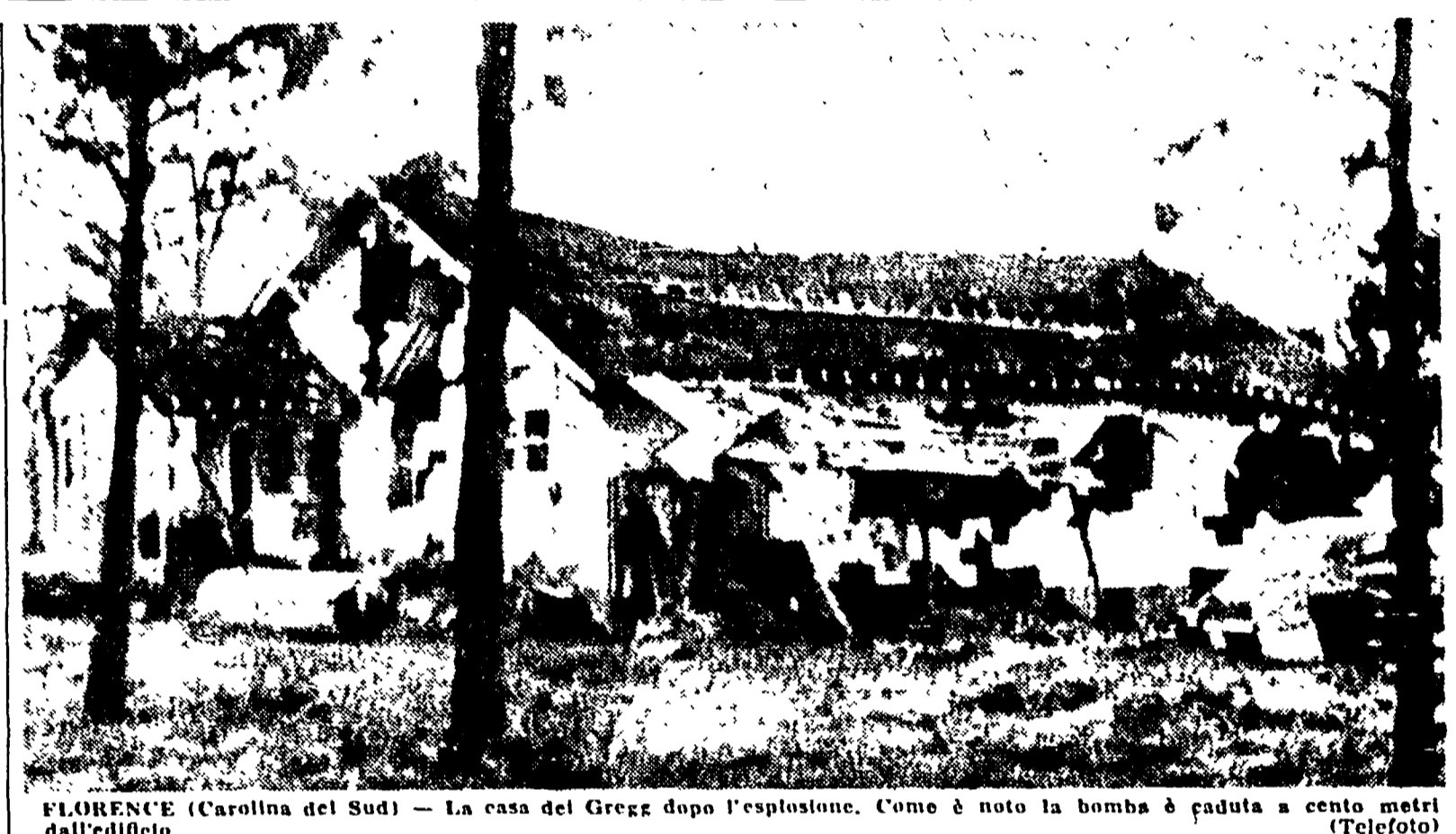
FLORENCE (Carolina del Sud) - La casa del Gregg dopo l'esplosione. Come è noto la bomba è caduta a cento metri dall'edificio (Telefoto)
