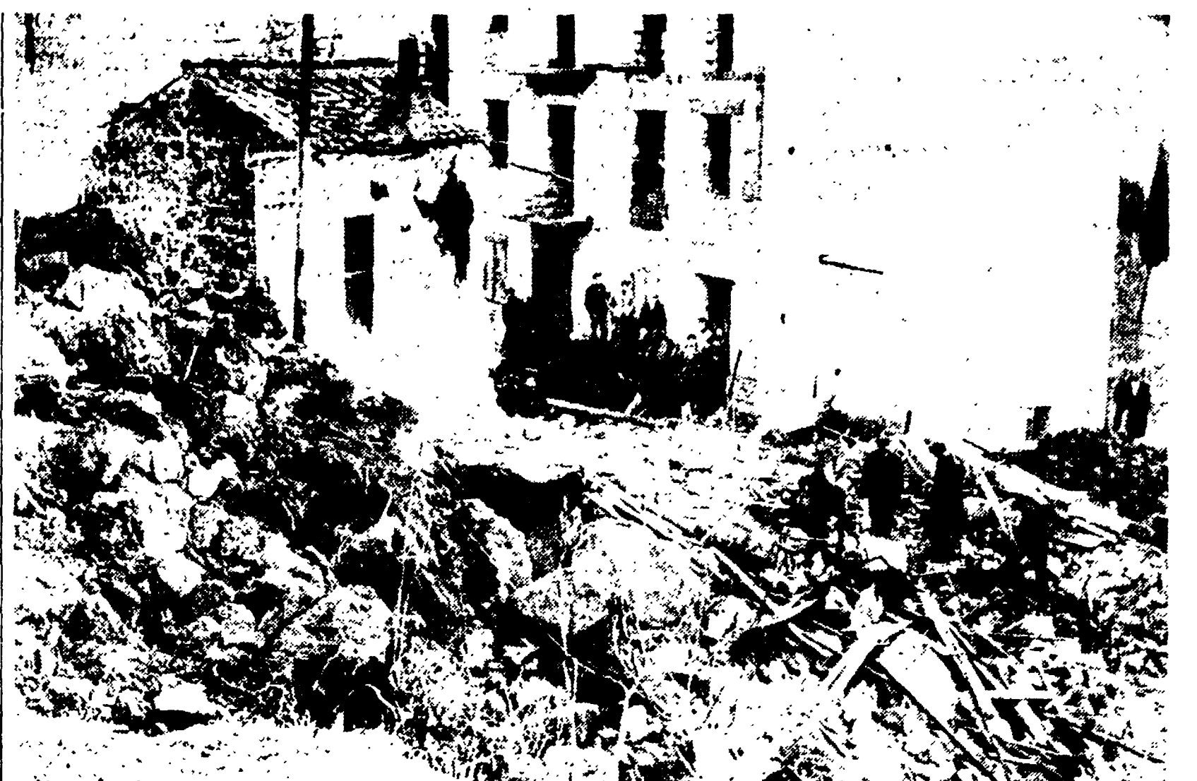
CASTELNUOVO DI PORTO - Ecco che cosa rimane del vecchio fabbricato dopo il tragico crollo
