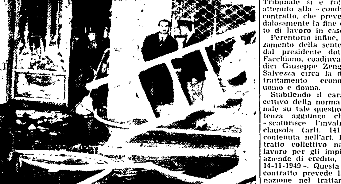
VIA FRANCESCO CRISPI — Una visione del negozio dopo il furioso incendio
