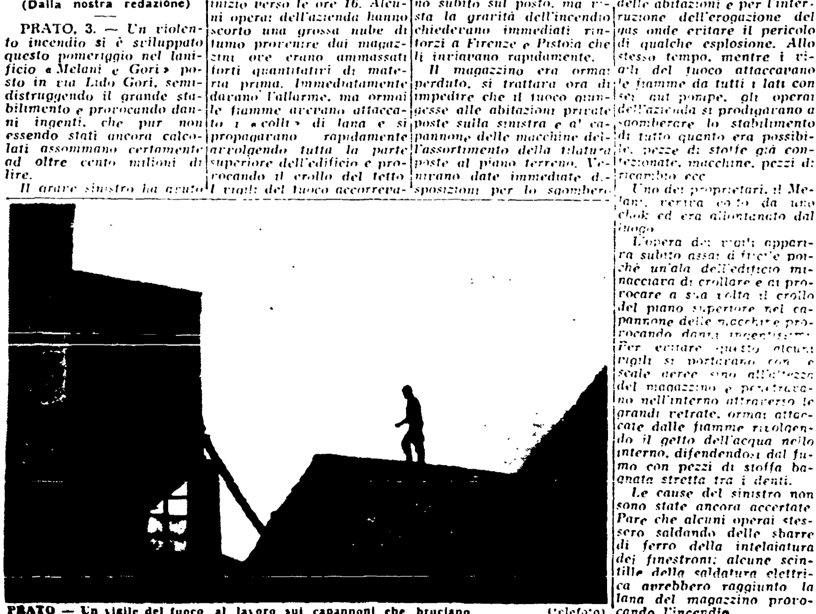
PRATO — Un vigile del fuoco al lavoro sui capannoni che bruciano
