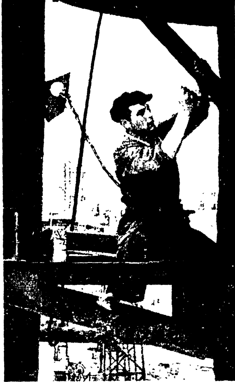
Un operaio fra le travature del cantiere sorto per l'ampiano degli stabilimenti chimici di Severodvinsk, in Ucraina.
