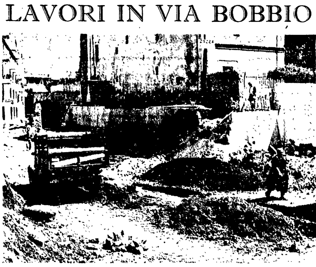
Ecco come appare via Bobbio, la strada che si diparte dall'Appia Nuova, vicino ad un grande emporio. Il livello stradale viene abbassato di circa 3 metri e gli abitanti, per "scendere" in istrada, devono usare una scala a pioli.
