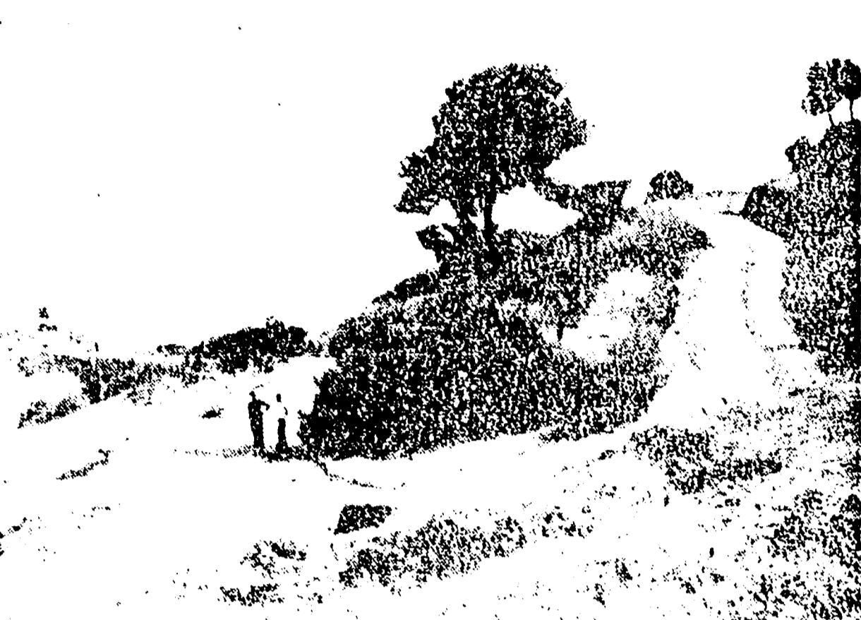
Questa è la strada provinciale di Abbadia (Reggio Calabria). Poco più di una miglia, esposta a tram, allagamenti, interruzioni, che rendono quanto mai precario il suo stesso traffico.
