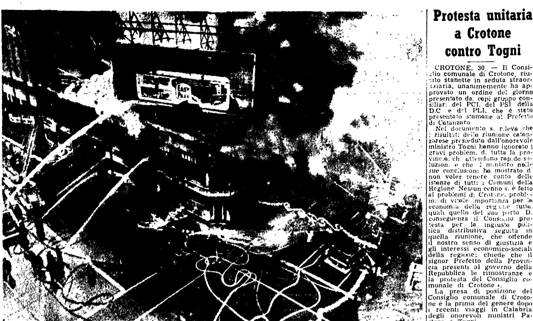
SCRANTON — Un grosso incendio è scoppiato nel centro d'affari della città distruggendo 21 edifici commerciali e provocando danni valutati ad un milione di dollari. Nella foto: una veduta semigerale dall'alto dal luogo del disastro. Enorme nuvola di fumo si alza dalle finestre del tetto di un edificio all'angolo di una via centrale di Scranton mentre gruppi di vigili del fuoco indagano e gettano acqua di molte pompe sulle fiamme. Per terra intorno al palazzo in fiamme si vedono le serpentine di decine di tubi che convogliano l'acqua alle pompe. Sul tetto dell'edificio avvolto dalle fiamme e dal fumo un grande cartello pubblicitario.
