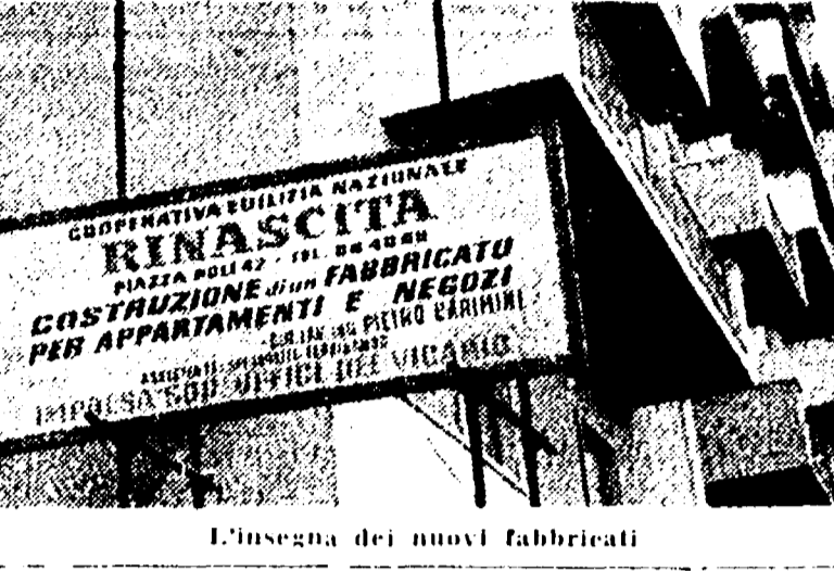
L'insegna dei nuovi fabbricati
