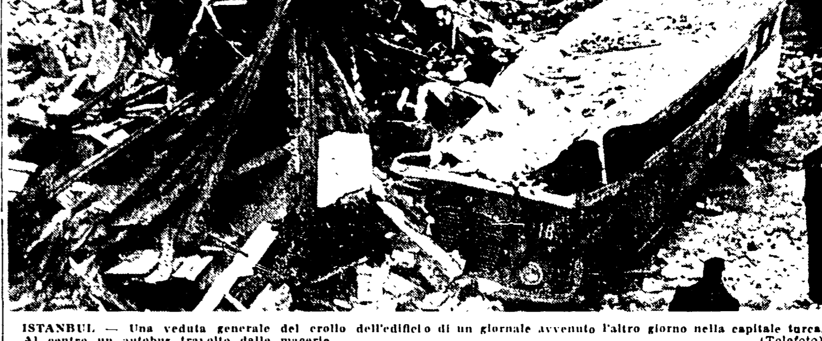
ISTANBUL. - Una veduta generale del crollo dell'edificio di un giornale avvenuto l'altro giorno nella capitale turca. Al centro un autobus travolto dalle macerie (Telefoto)
