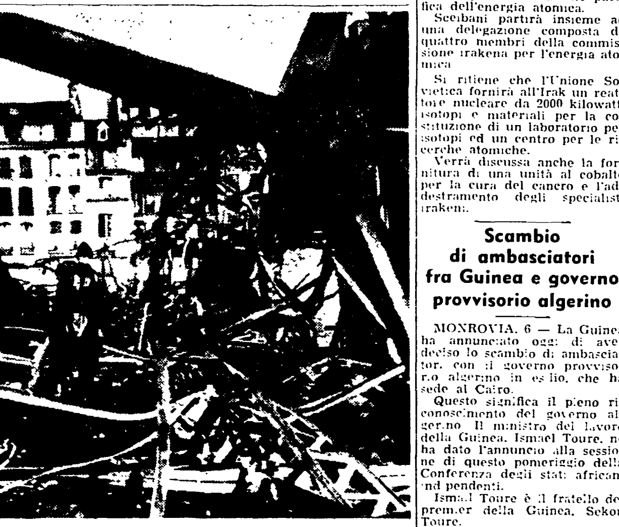
PARIGI - Una drammatica visione di ciò che è rimasto del grande magazzino dei mercati generali dopo il violento incendio (Telefoto)
