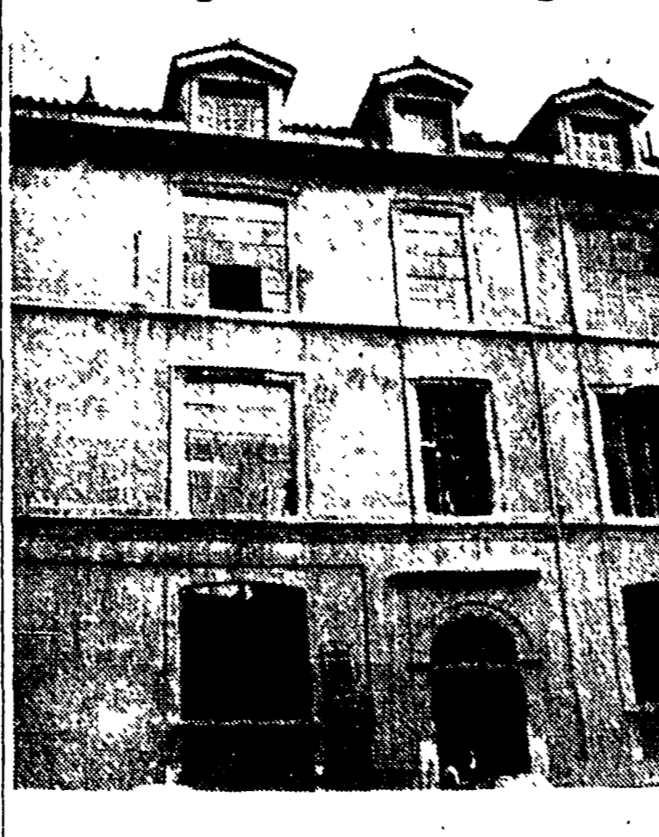
I vigili del fuoco hanno effettuato nei giorni scorsi una ispezione a via Margutta 51 per controllare le condizioni dell'edificio...
