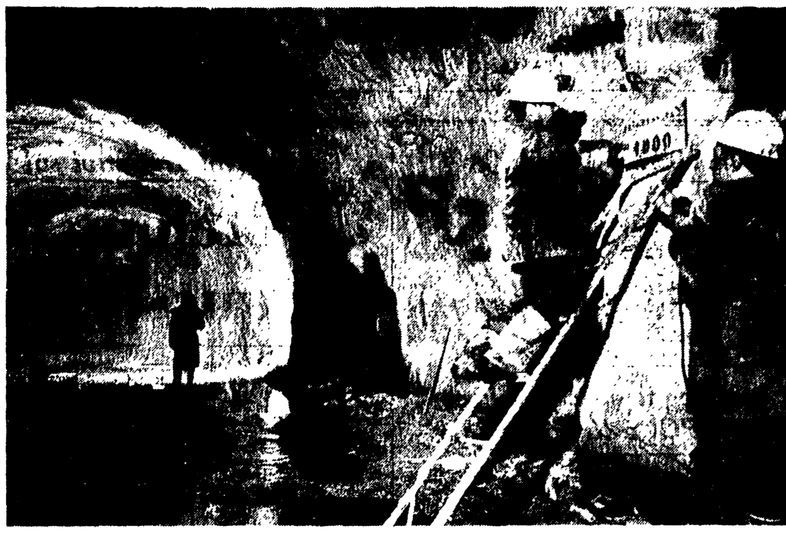
MONTE BIANCO — Proseguono alacremente i lavori di perforazione della galleria che unirà Pitalia alla Francia. Dalla parte italiana è stato ormai raggiunto il primo chilometro, dopo una serie di difficoltà superate al previsto a causa dello stato del terreno. Un cartello affisso alla parete rocciosa indica la distanza raggiunta.
