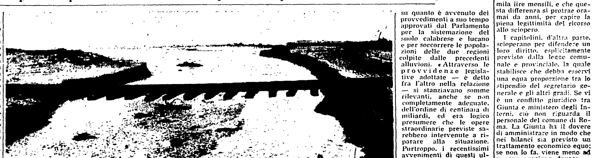
CROTONE - Un'impressionante aprito delle inondazioni in Calabria. E' visibile un tratto della linea ferroviaria Crotone-Melissa sospesa nel vuoto dopo che l'acqua del fiume ha distrutto il ponte che la sosteneva (Telefoto)
