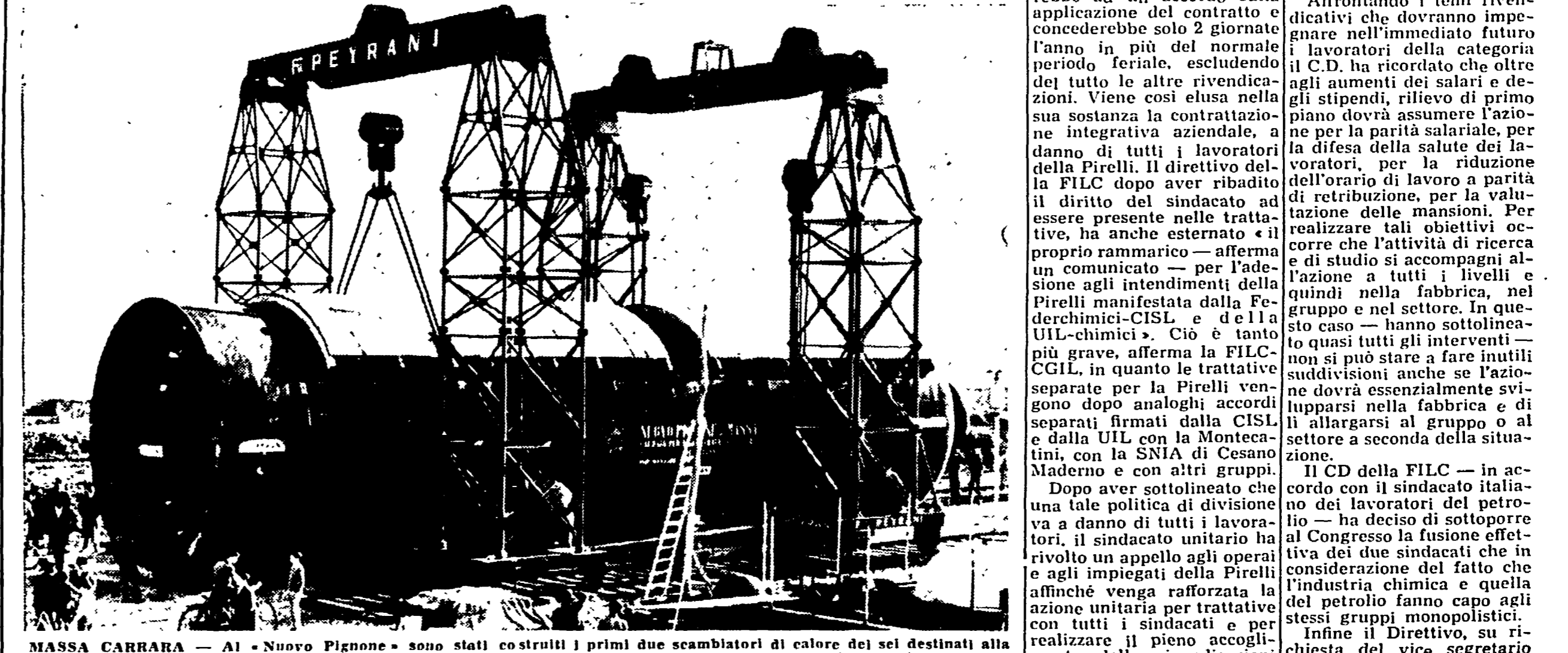
MASSA CARRARA — Al «Nuovo Pignone» sono stati costruiti i primi due scambiatori di calore del sel destinati alla centrale elettronucleare di Latina. Le caldaie di gigantesche dimensioni saranno varate su appositi carrelli a Marina di Massa e rimorchiato via mare fino al lido di Latina
