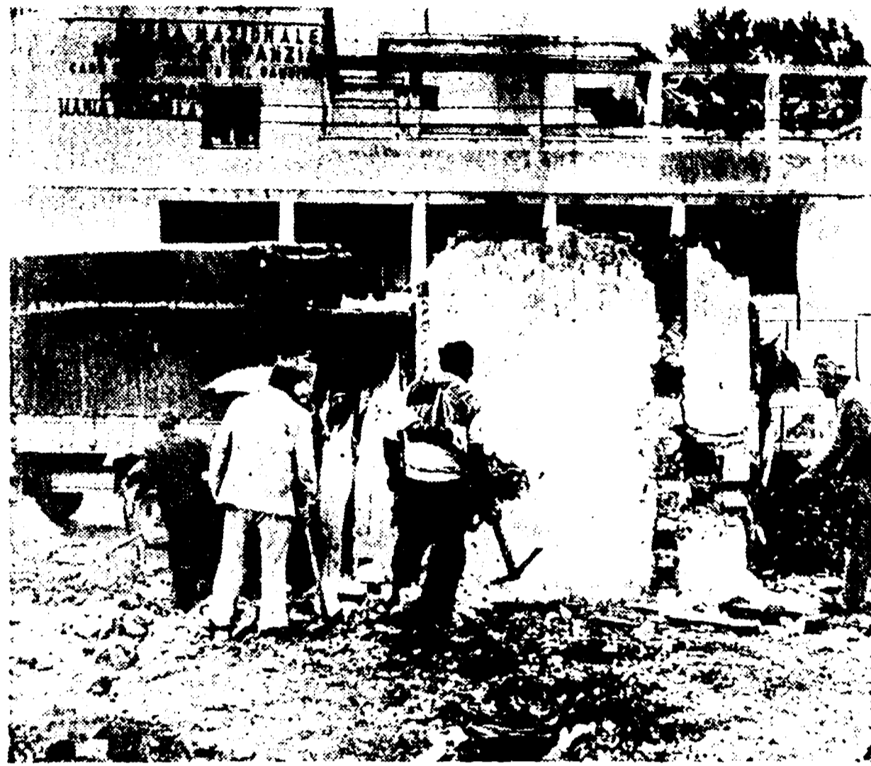
Gli operai cominciano l'opera di demolizione
