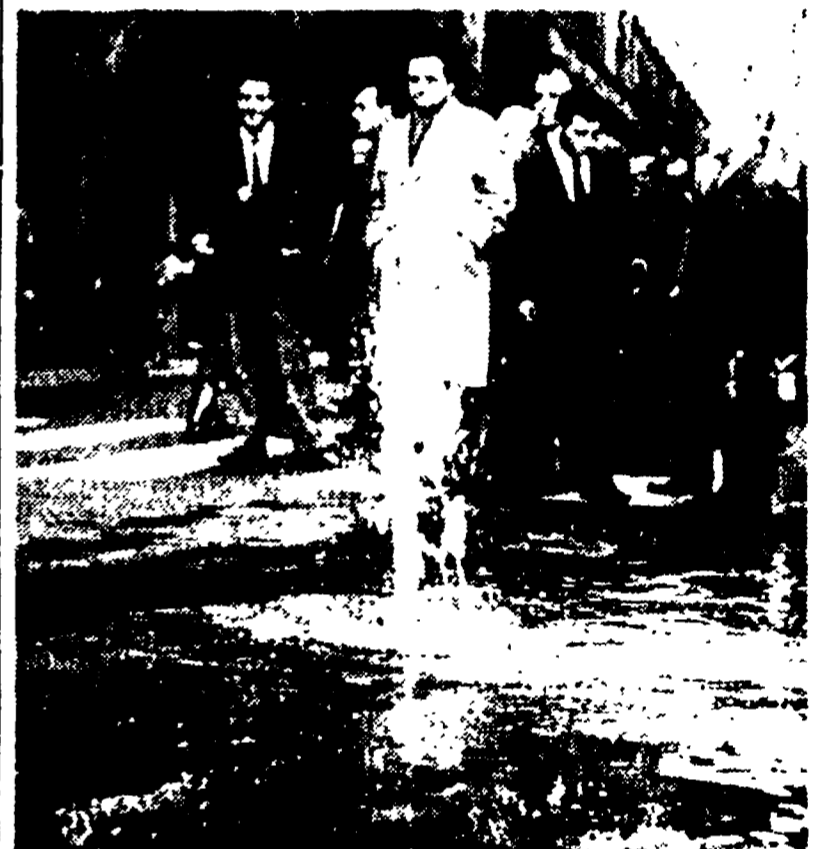
In questo tratto di strada fra piazza Mignacelli e via Due Macelli è scoppiata ieri a mezzogiorno una tubatura dell'Acqua Marcia. L'acqua, con la forza della pressione, ha dapprima formato delle piccole irregolarità sulla superficie stradale ed è quindi zampillata in più punti. Alla falla non si è potuto rimediare che sospendendo l'erogazione dell'acqua nella zona. Il traffico è stato temporaneamente deviato
