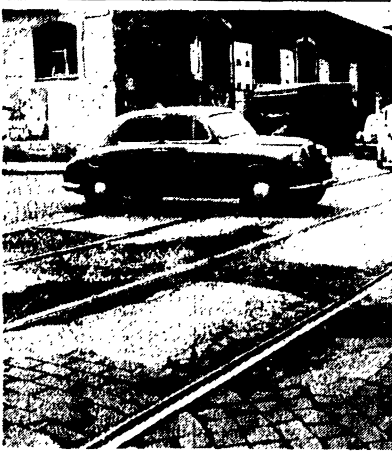
LA PRATICA - Via Filippo Turati, all'incrocio con via Lamarmora, qui non si capisce bene quale pavimentazione si tratti. Il tratto a destra è in selciato, con i selci sconnessi, dato che il sigillo di bitume se n'è andato da chissà quanto tempo e nessuno ha provveduto a rifarlo. Il tratto superiore dovrebbe essere in macadam bitumato. Dovrebbe essere potché gli strati di bitume sono scomparsi e le automobili corrono sul pietrisco di selce. Con buona pace dei pneumatici
