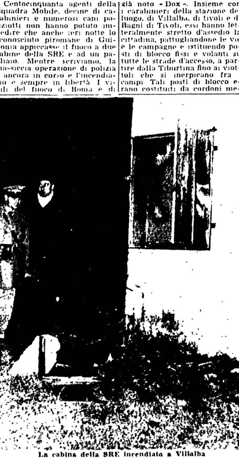
La cabina della SRE incendiata a Villalba
