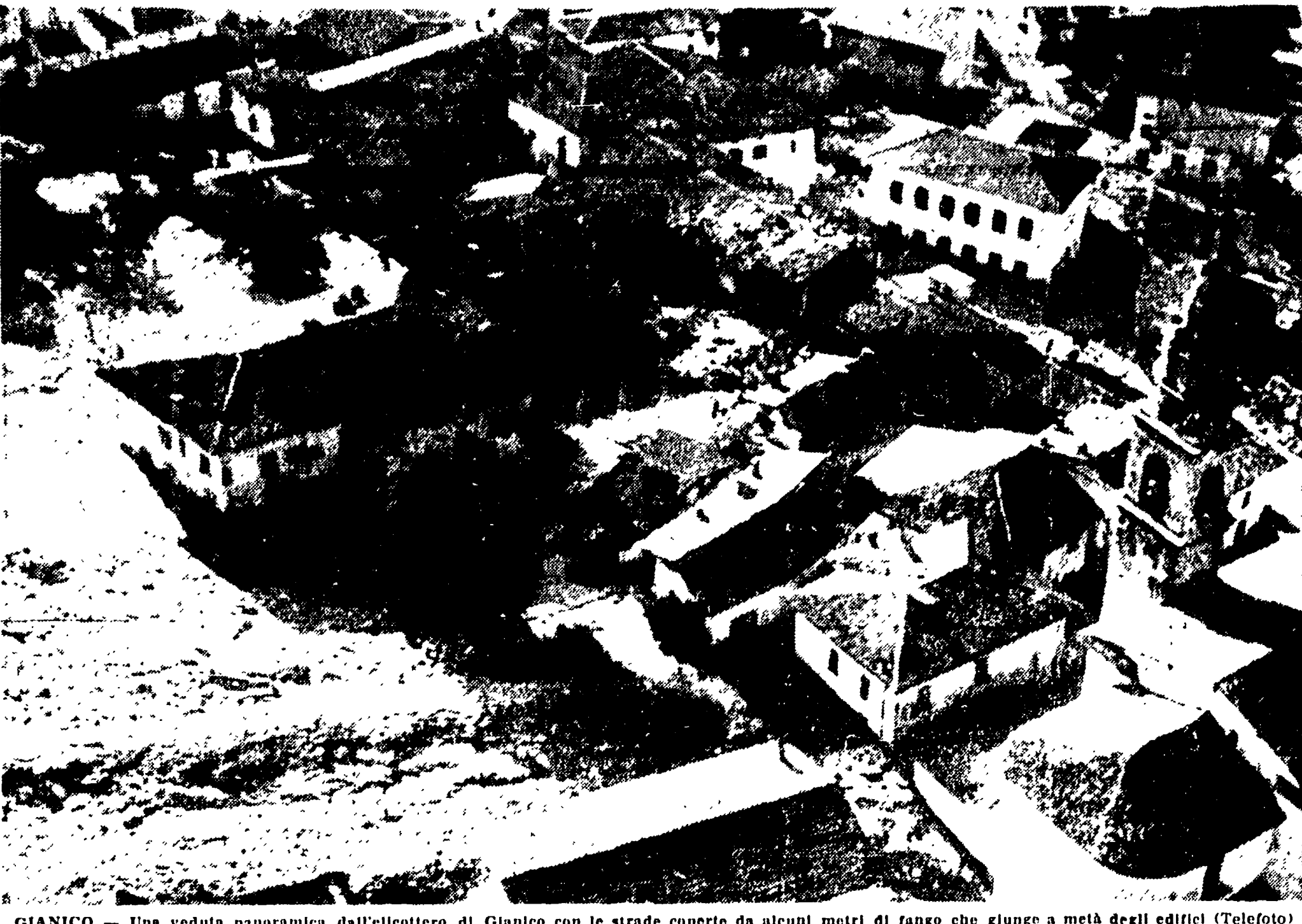
GIANICO — Una veduta panoramica dall'elicottero di Gianico con le strade coperte da alcuni metri di fango che giunge a metà degli edifici (Telefoto)
