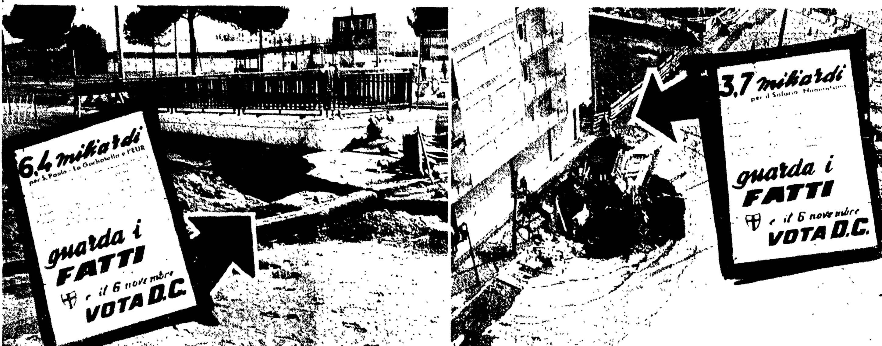
Risultati della amministrazione Ciocchetti: a sinistra una voragine aperta in via Somalia; a destra lo sprofondamento di viale Cristoforo Colombo...
