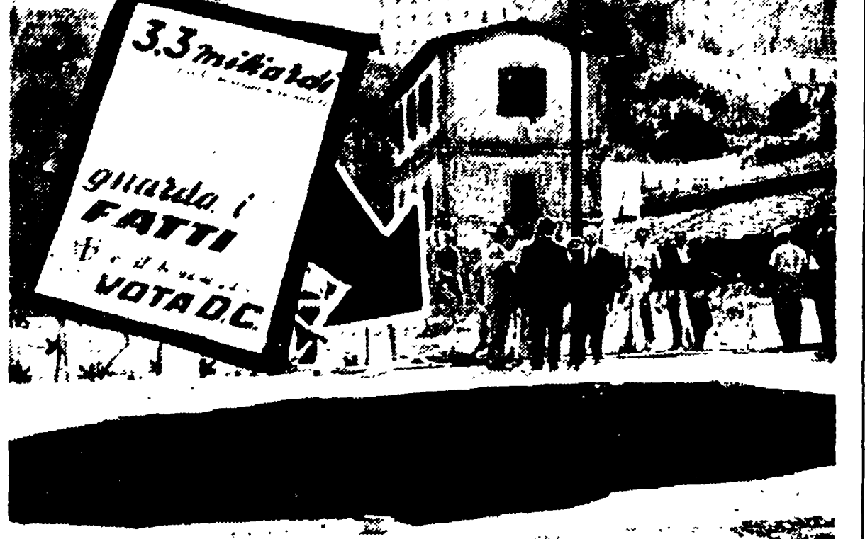
TRIONIALE - Per questo quartiere, secondo la D.C., sono stati spesi 3 miliardi - 200 milioni. Nella foto, la profonda voragine che si è aperta in via Angelo Emo
