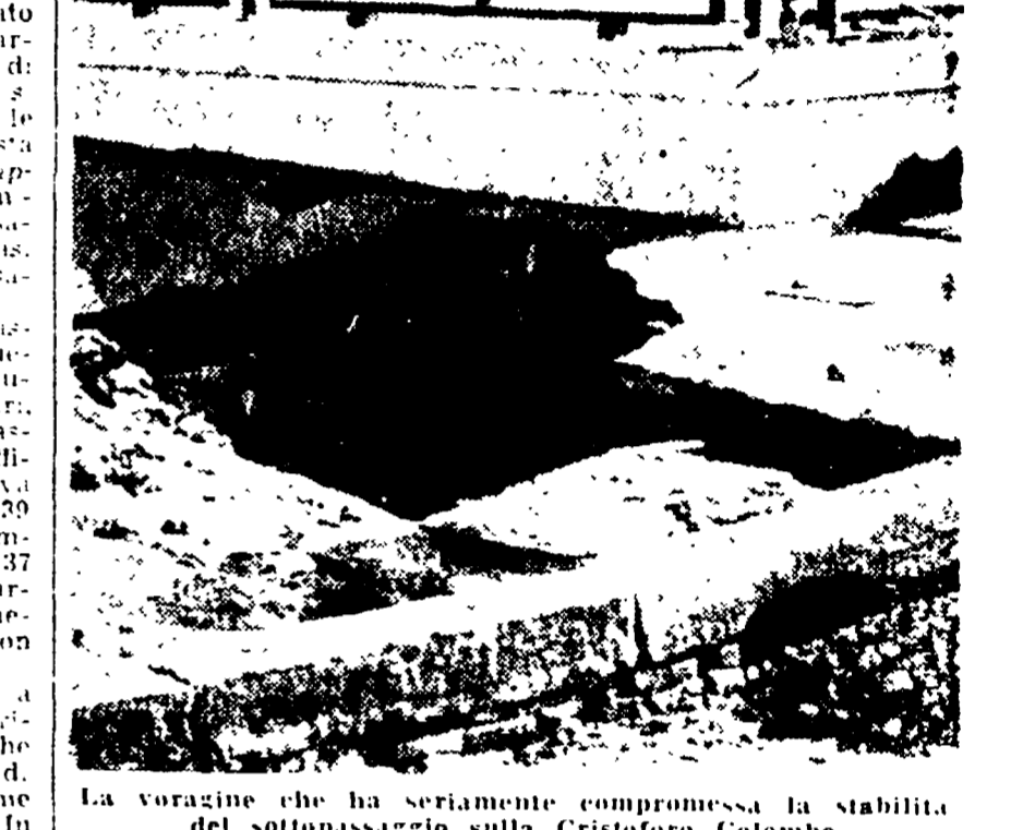
La voragine che ha seriamente compromessa la stabilità del sottopassaggio sulla Cristoforo Colombo
