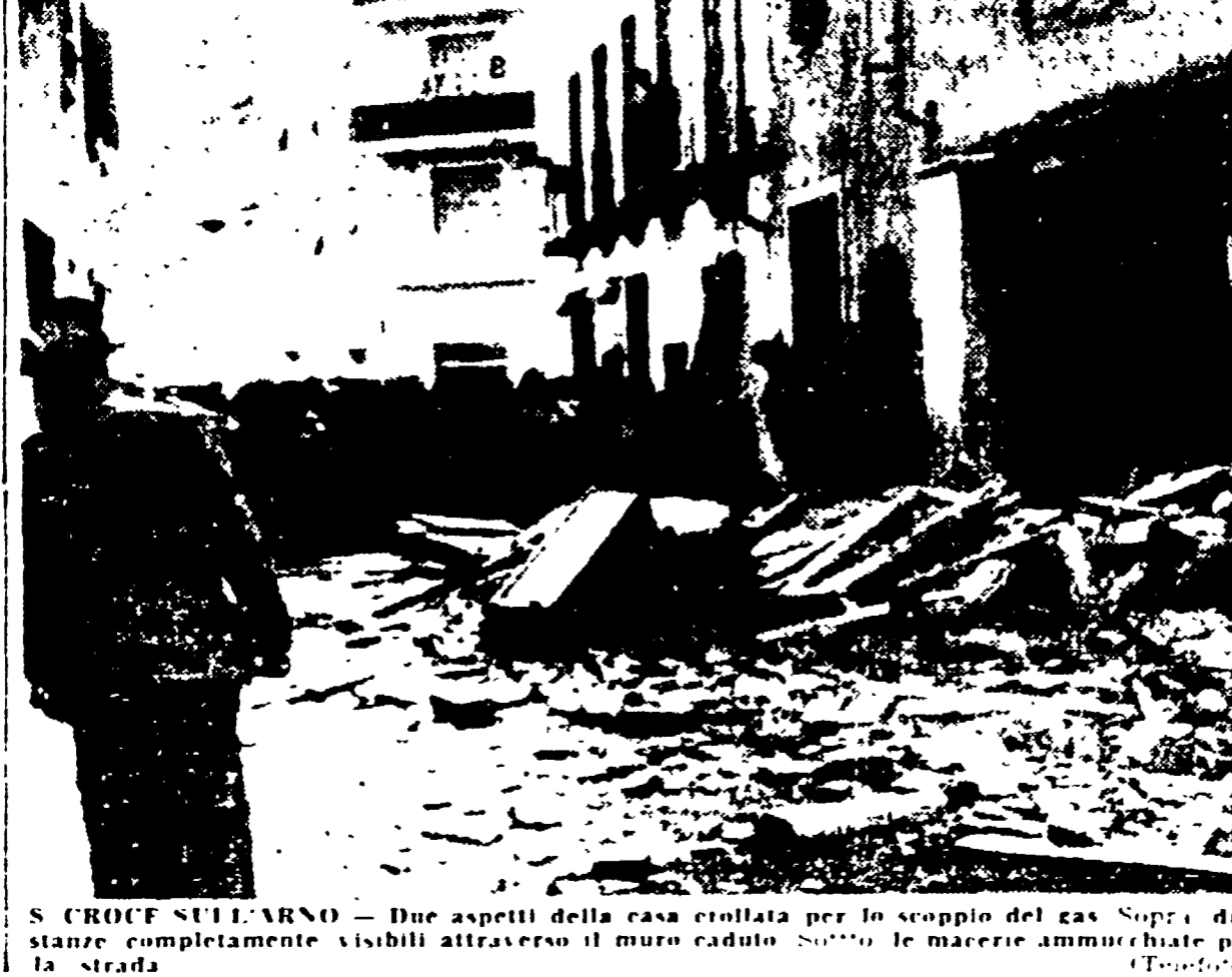
S. CROCE SULL'ARNO — Due aspetti della casa crollata per lo scoppio del gas. Sopra: due stanze completamente visibili attraverso il muro caduto. Sotto: le macerie ammassate sulla strada.
