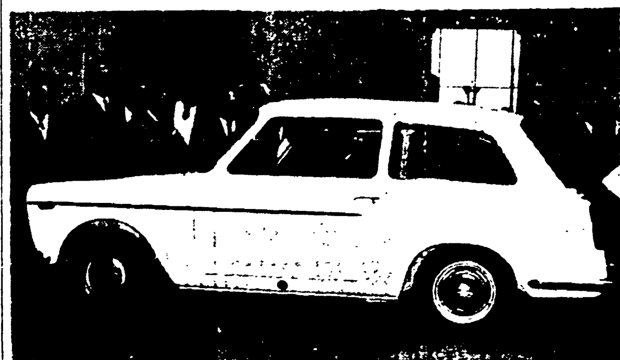
LA NUOVA VETTURA « INNOCENTI-AUSTIN A-40 » — L'auto a quattro posti, ha due sportelli e lunge 3 metri e 66, alta 1 metro e 44, larga 1 metro e 51. Il motore è a quattro cilindri, la cilindrata è di 918 cc. La velocità massima che la vettura può sviluppare è di 113 chilometri l'ora. Il consumo è di un litro ogni 16 chilometri. L'automobile costa nell'edizione normale, 800 mila lire mentre la versione detta « combinata » ha un prezzo di 810 mila lire.
