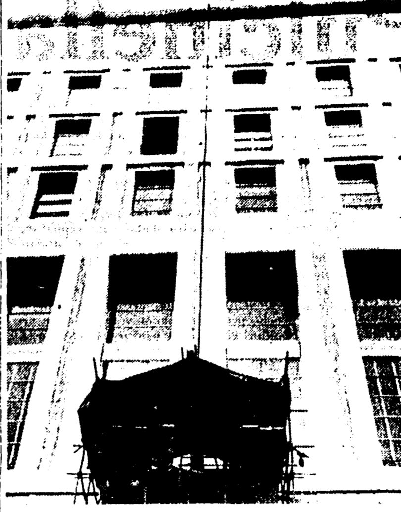
La foto mostra la profonda fenditura che, dall'alto fino alle fondamenta, è venuta fuori alla Farnesina...
