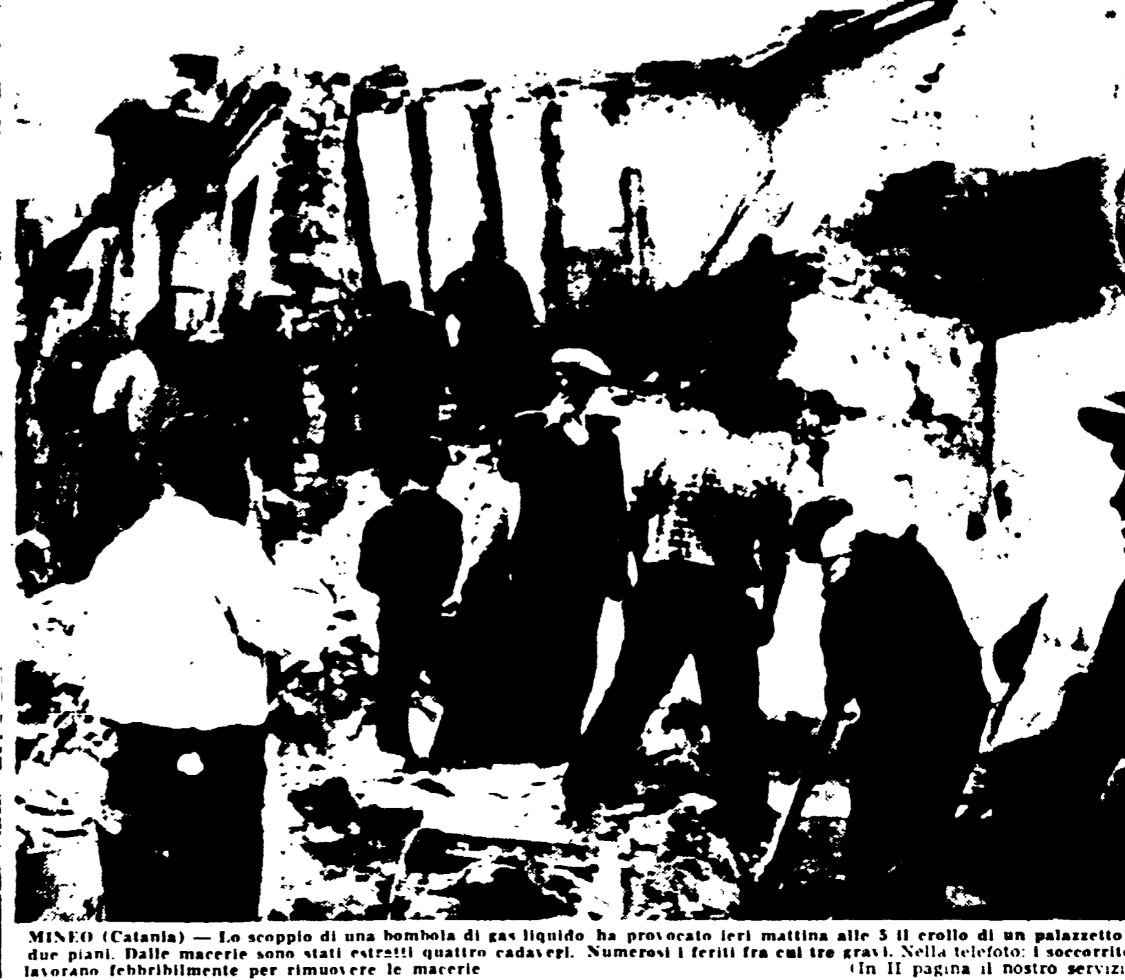
MINEO (Catania) - Lo scoppio di una bombola di gas liquido ha provocato ieri mattina alle 5 il crollo di un palazzetto di due piani. Dalle macerie sono stati estratti quattro cadaveri. Numerosi i feriti fra cui tre gravi. Nella foto: i soccorrittori (In II pagina il nostro servizio)
