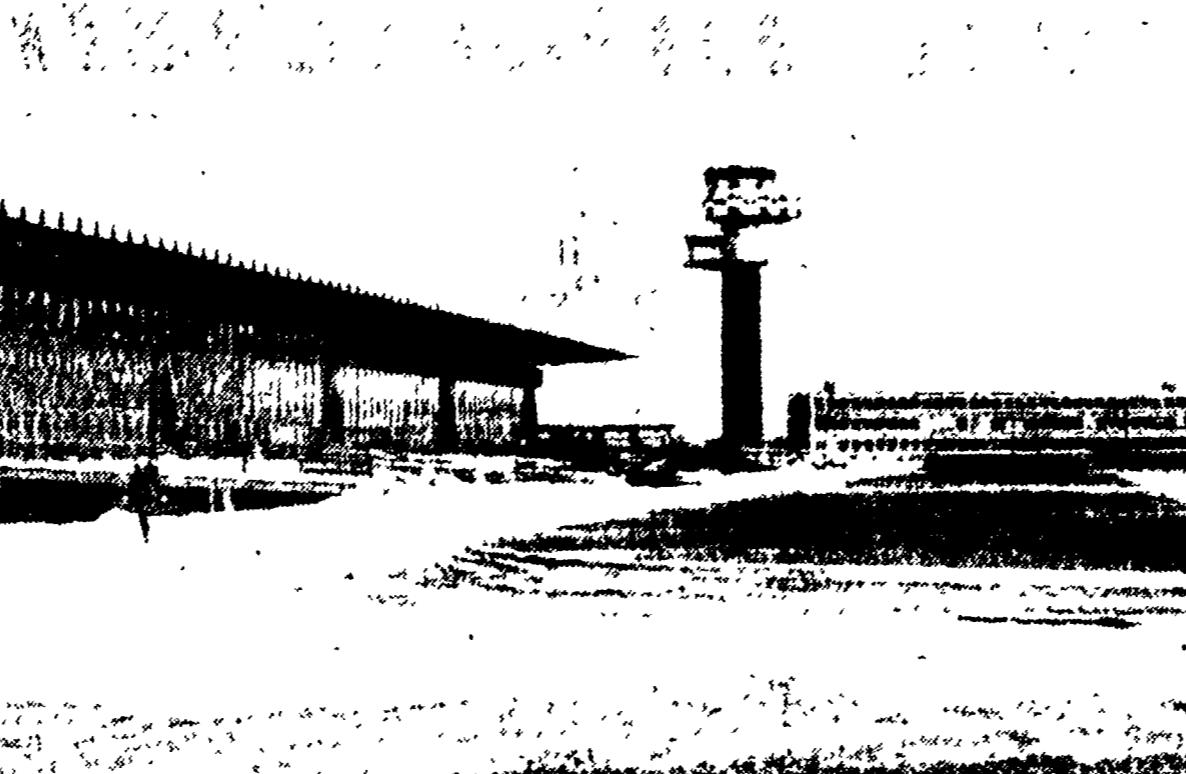
La grande torre di controllo dell'aeroporto di Fiumicino, alta 31 metri, è tuttora priva di strumentazione e si è rivelata inutilizzabile perché i vetri si frantumavano al sillo del reattori. L'è in costruzione ora una apposita trincea frangivande sonore per permettere in futuro la utilizzazione
