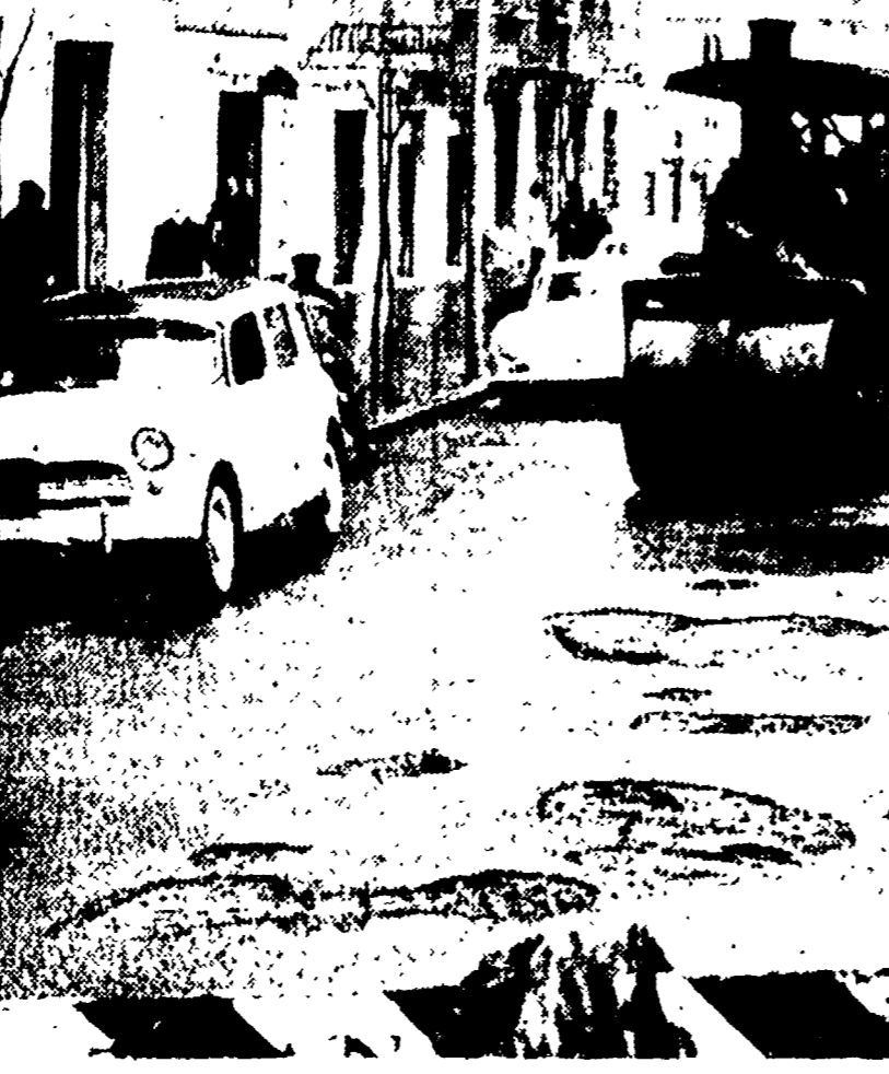
Secondo giorno dell'operazione - riempimento buche - e già se ne vedono delle belle. In alcune strade le buche vengono colmate con una spruzzatina di asfalto, come mostra la fotografia che pubblichiamo; in altre si oltrepassa ogni limite. Per fare un esempio, in via Salaria, di fronte all'Istituto Serravallo, le buche profonde un palmo sono state colmate con un impasto di terra e di acqua. In altre parolacce, il fango pressato. In questo modo, prendendo vergognosamente in giro i contribuenti e i cinque miliardi in un anno sborsati dal Comune per pagare le imprese che non eseguono la manutenzione stradale, si crede di poter mettere tutto a tacere e poter tornare a parlare di altro.
