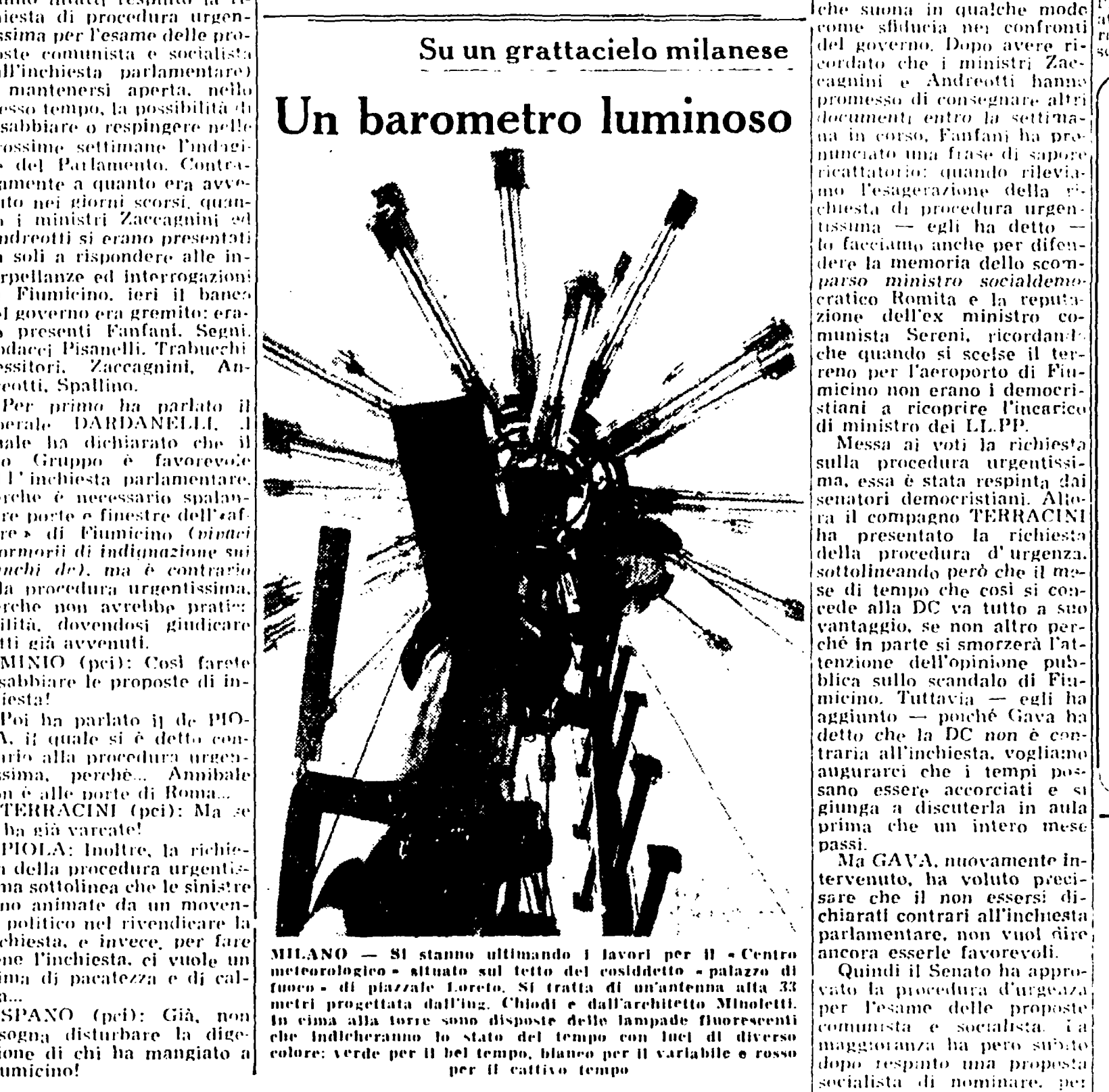
MILANO — Si stanno ultimando i lavori per il « Centro meteorologico » situato sul tetto del cosiddetto « palazzo di fuoco » di piazzale Loreto. Si tratta di un'antenna alta 33 metri, provvista di una scala a elica, e di un sistema di rilevamento in cima alla torre sono disposte delle lampade fluorescenti che indicheranno lo stato del tempo con luci di diverso colore: verde per il bel tempo, bianco per il variabile e rosso per il cattivo tempo.
