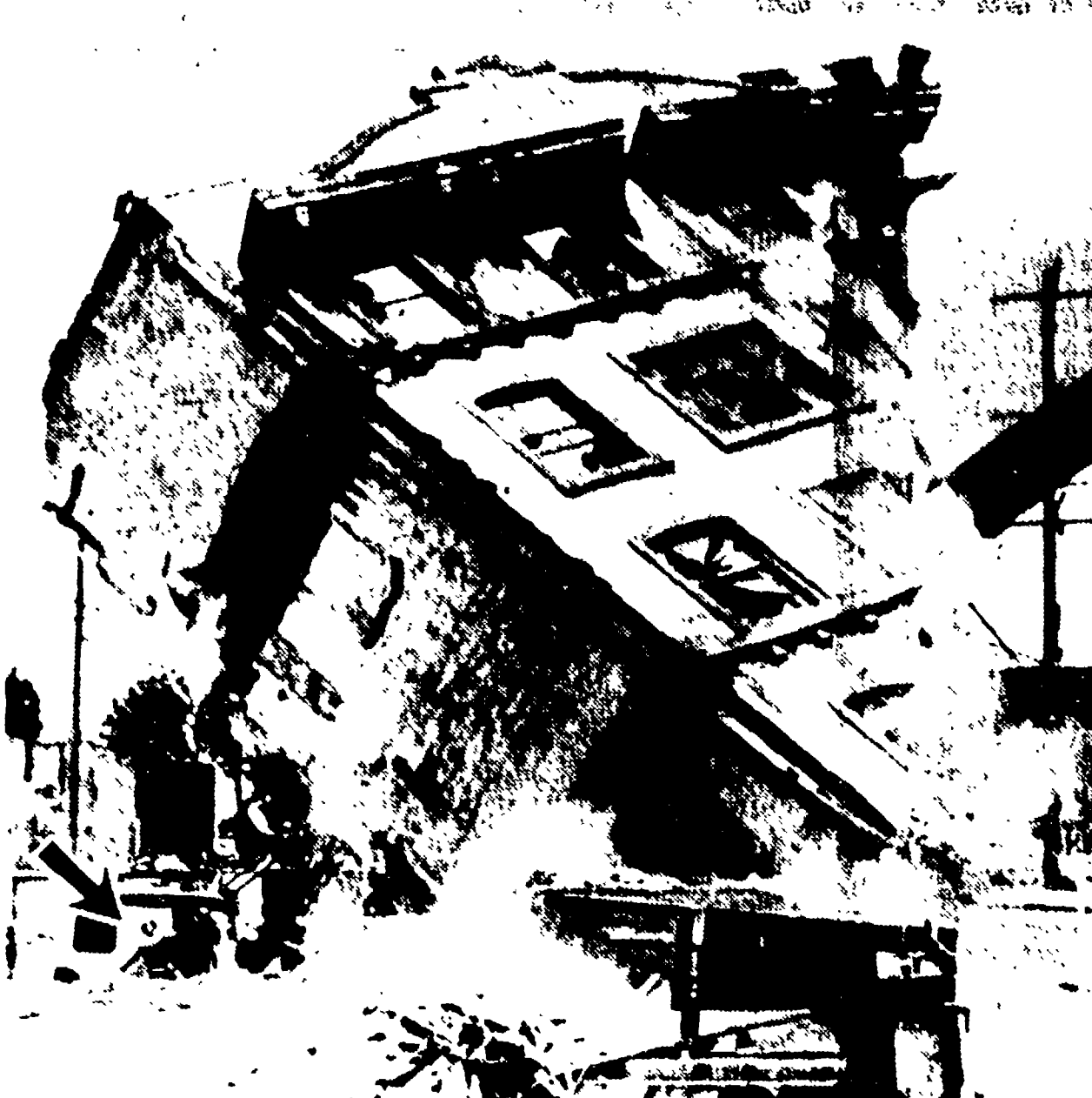
PORTLAND — Il manovratore di una gru (segnata dalla freccia) fuera dalla sua cabina nel crollo di un albergo di quattro piani, salvato all'ultimo istante mentre si iniziavano i lavori di demolizione. Si è salvato all'ultimo istante. (Del foto)
